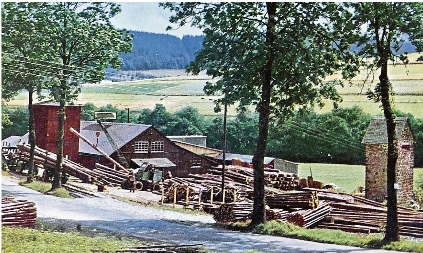
Blick auf das Sägewerk Jessen am Rande Schwalefelds. Vorn wird gerade angeliefertes Stammholz entladen. Rechts steht eine Transformatorenstation. Von dort aus wurde das Werk mit Strom versorgt. REPOS: KARL-FRIEDRICH TRACHT
